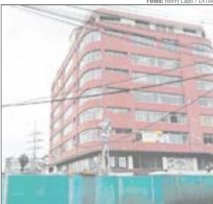
Este edificio, ubicado entre la Versailles y Pérez Guerrero, es el más afectado por el cierre.
