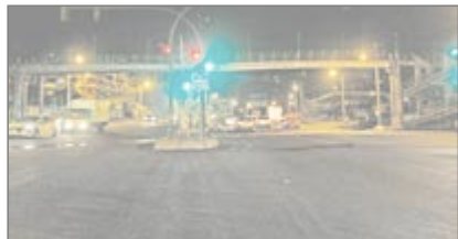
A pesar de que hay un puente, muchas personas no lo usan y cruzan por la avenida.
