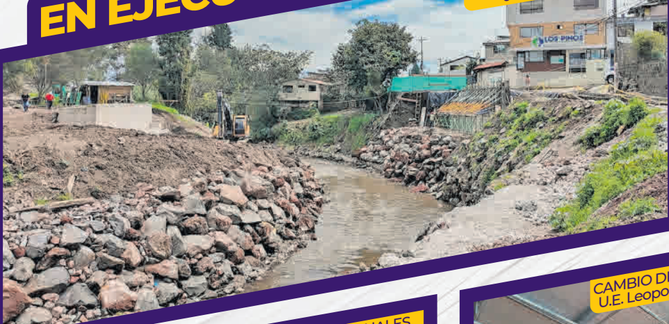
PUENTE CALLE LOS PINOS Jardines de Capelo
