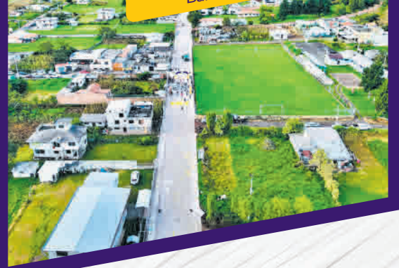
ADOQUINADO Y ALCANTARILLADO CALLE RÍO SAN PEDRO Barrio San Fernando
