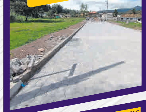
ADOQUINADO Y ALCANTARILLADO CALLE KURRUBA Cotogchoa
