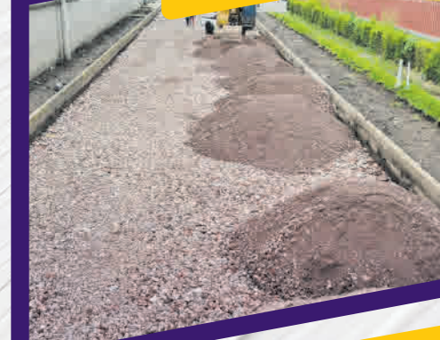
ASFALTADO CALLE TANICUCHI Cotogchoa
