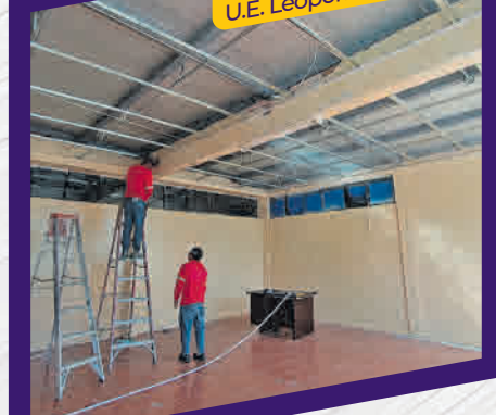
CAMBIO DE CUBIERTAS U.E. Leopoldo Mercado
