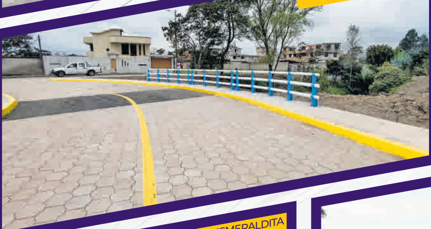
PUENTE COLORADOS Fajardo
