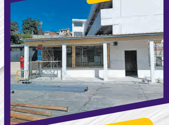
CAMBIO DE CUBIERTAS U.E. Carlos Larco
