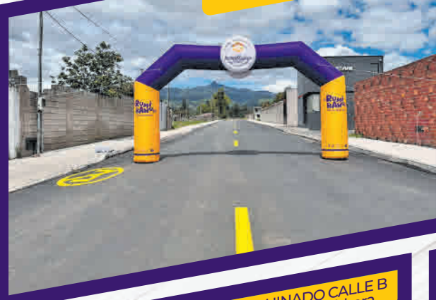
ASFALTADO CALLE REMACHE Cotogchoa
